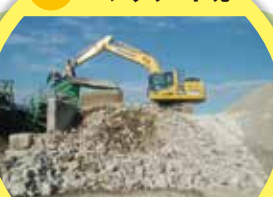
建設廃材等の コンクリートを集める
