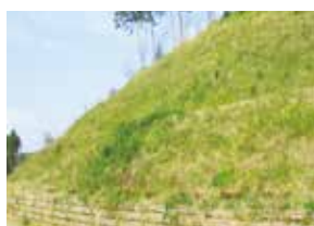
法面緑化の資材に
