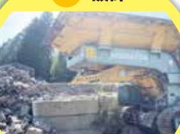
破碎機にて破碎
