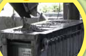
コンクリート投入締固め
