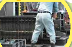
製品の型枠組立
