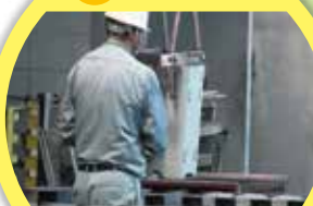
脱型・出荷までの養生
