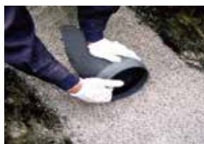
水道管の保護砂
