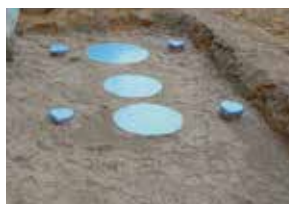
浄化槽の埋め戻し
