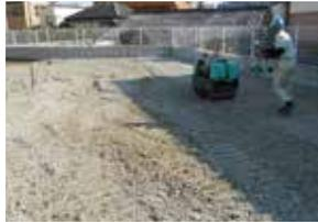
アスファルト舗装の路盤材
