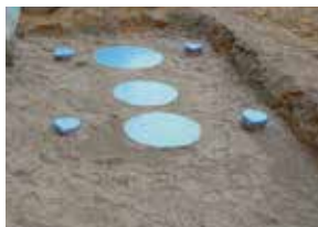
浄化槽の埋め戻し
