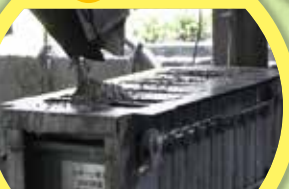
コンクリート投入締固め
