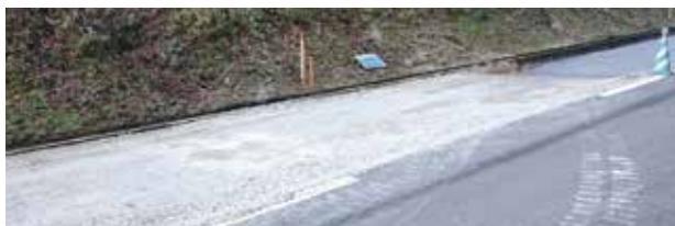
アスファルト舗装の路盤材
