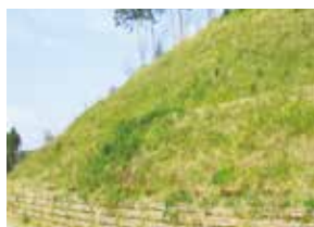
法面緑化の資材に
