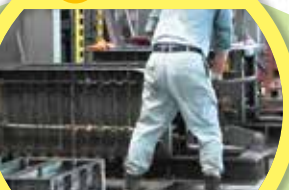
製品の型枠組立
