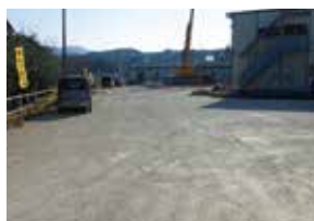
敷き均し資材として
