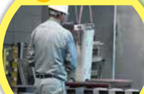
脱型・出荷までの養生
