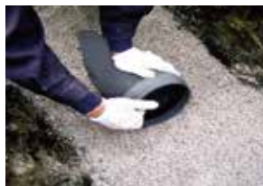
水道管の保護砂
