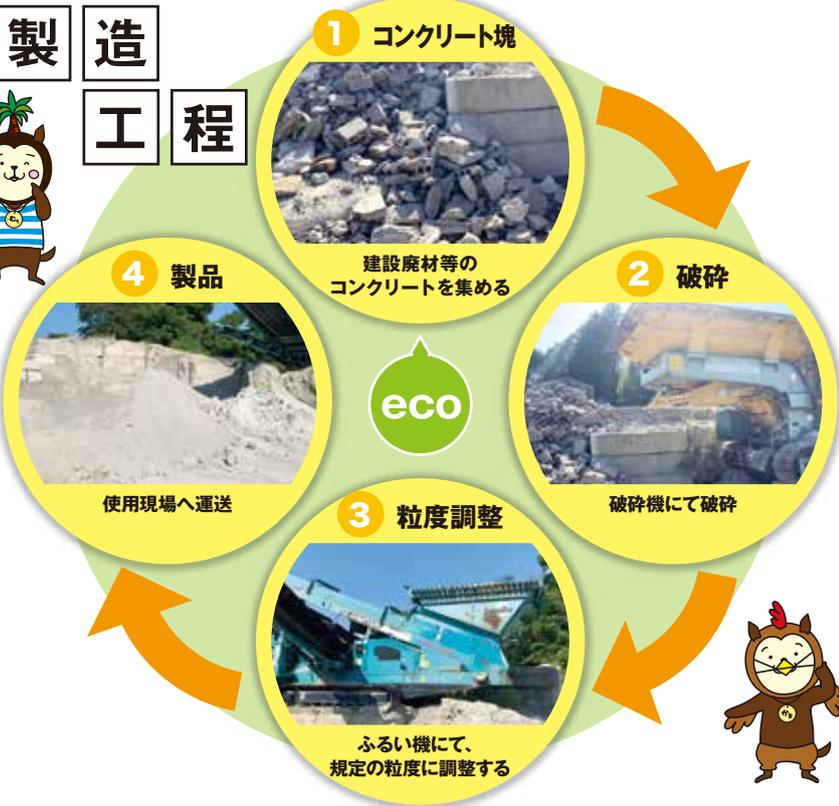
建設現場等から出る建設廃材のコンクリート塊を破碎し製造します。破碎機により細かく砕いたコンクリート塊をふるいにかけて、一番粒度の小さいものを再生砂として再活用します。粒度が小さい事を利用して、水道管などを埋める際にできる隙間を埋めるなどの保護材として利用します。
