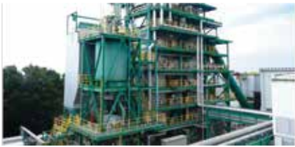
バイオマスボイラの流動砂として
