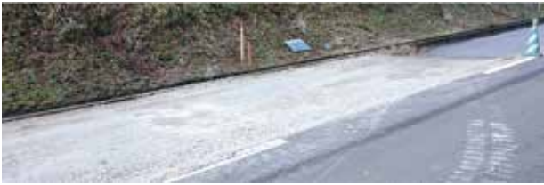
アスファルト舗装の路盤材
