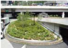
地下駐車場の上部植栽工事など
