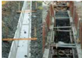
土木工事補足材など
