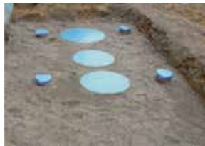
浄化槽の埋め戻し
