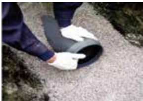
水道管の保護砂
