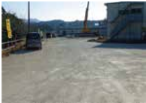
敷き均し資材として
