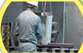
脱型・出荷までの養生
