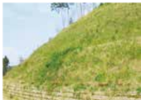
法面緑化の資材に
