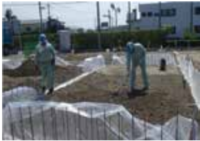
建築現場土間コンクリートの基礎砕石
