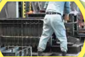
製品の型枠組立
