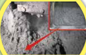
コンクリート練り混ぜ（フライアッシュ混入）
